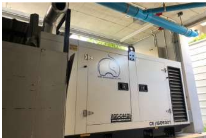
ภาพที่ 20 เครื่องสำรองไฟฟ้า
