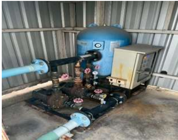
ภาพที่ 13 ปั๊มแรงดันน้ำ
